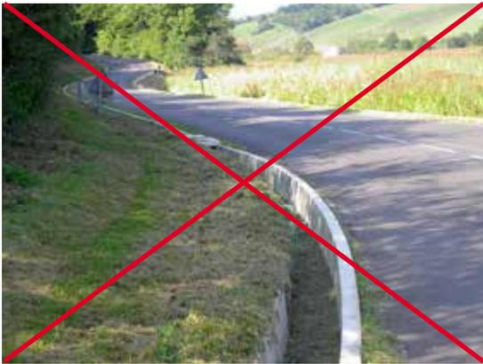
Figura 11.12. Las zanjas de recogida de anfibios que los conducen a entradas de pasos ubicadas en su interior, constituyen trampas para animales de pequeño tamaño. Foto: C. Rosell.
