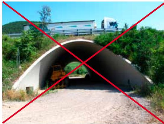
Figura 7.8. Uso inadecuado del interior de un paso inferior multifuncional para estacionar maquinaria. Foto: M. Fernández Bou.
