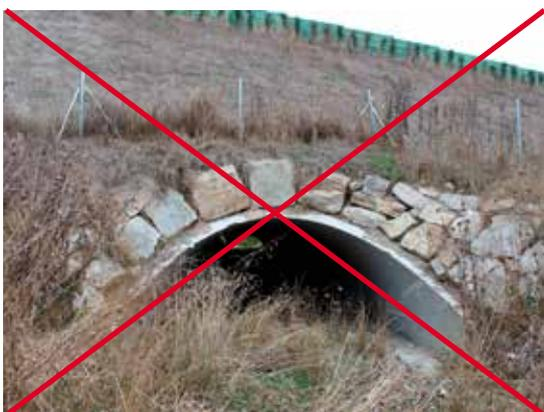
Figura 12.7. Instalación incorrecta del cerramiento perimetral, ya que no guía a los animales a las entradas del paso. Foto: M. Fernández-Bou.
