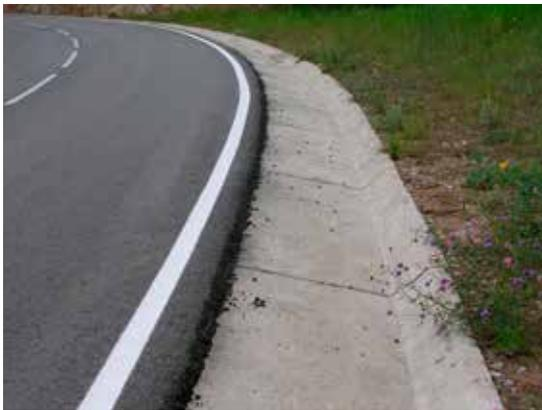
Figura 20.2. Cuneta que permite un fácil acceso a los márgenes de la vía de los animales que hayan cruzado la calzada. Foto: F. Navàs.
