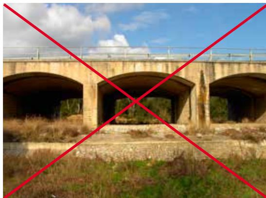
Figura 5.10. Puente con la superficie hormigonada bajo su luz, que impide la continuidad de la vegetación de ribera. Foto: Minuartia.
