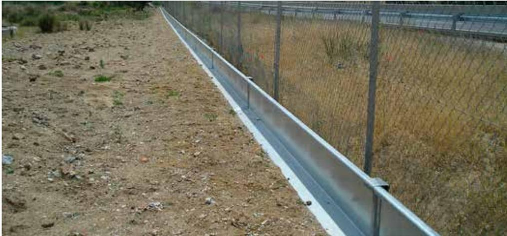
Figura 11.6. Estructura opaca de metal aplicada a un cerramiento perimetral para guiar los anfibios a los pasos. Foto: CEDEX.
