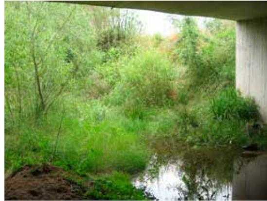
Figura 12.4. La existencia de vegetación natural hasta la entrada del drenaje facilita la conducción de los animales, favoreciendo su funcionalidad. Foto: M. Fernández Bou.
