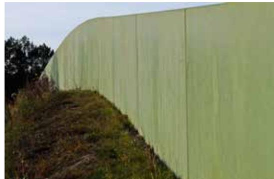
Figura 1.7. Las pantallas de madera tratada o placas de hormigón tintado requieren menor mantenimiento que la vegetación. Foto: C. Rosell.
