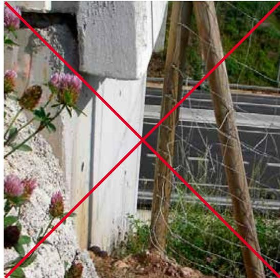
Figura 13.13. Ajuste deficiente entre la valla y la aleta del paso. Foto: F. Navàs.
