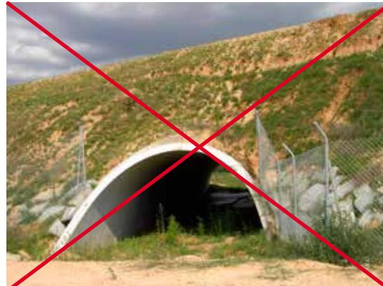
Figura 6.10. El cerramiento no se ha aplicado correctamente a las paredes de la bóveda, permitiendo el acceso de animales a los taludes. Foto: C. Rosell.
