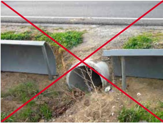
Figura 11.10. Desajuste entre la estructura de guía y el acceso al paso para anfibios. Foto: C. Rosell.
