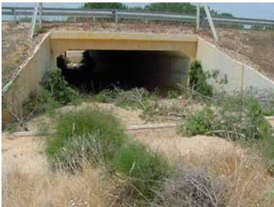
Figura 12.5. La disposición de hileras de ramas y las re-vegetaciones facilitan la conducción de la fauna hacia el interior de la estructura. Foto: P. Robles.
