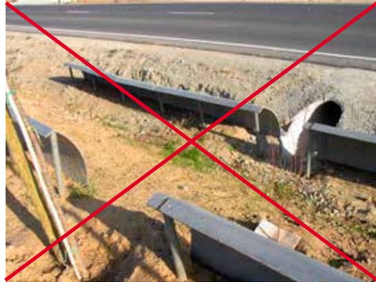
Figura 11.11. Discontinuidad entre distintos tramos de la vallas de guía. Foto: F. Navàs.
