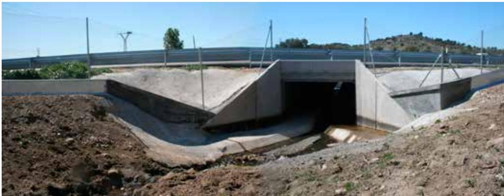
Figura 11.7. Cerramiento que conduce a los anfibios hacia un paso de fauna en construcción. Foto: Javier Cantero.
