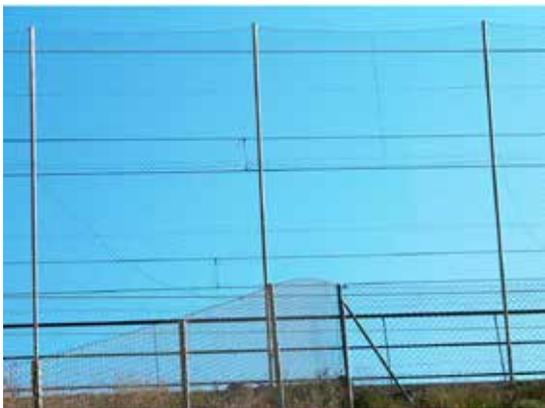
Figura 14.4. Cerramiento anticolidión para murciélagos de 5 m de altura y malla de simple torsión en una línea de alta velocidad. Foto: ADIF.
