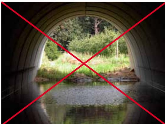
Figura 6.9. La inundación completa de la base de la estructura dificulta el paso de la fauna. Foto: C. Rosell.
