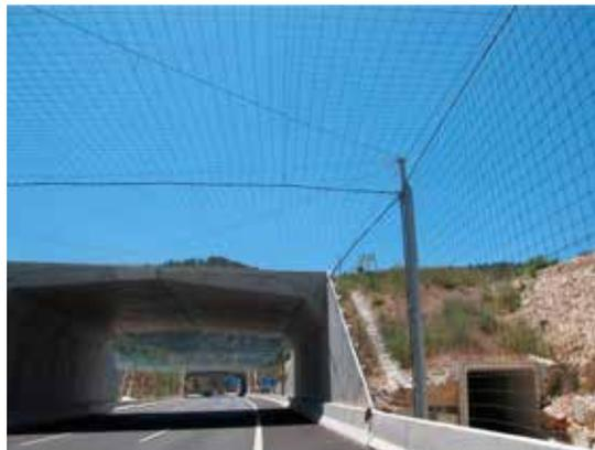
Figura 14.5. Estructura de red de poliamida en forma de túnel para prevenir la colisión de murciélagos en una carretera, cuya evolución no ha aportado todavía resultados concluyentes. Foto: M. Fernández Bou.
