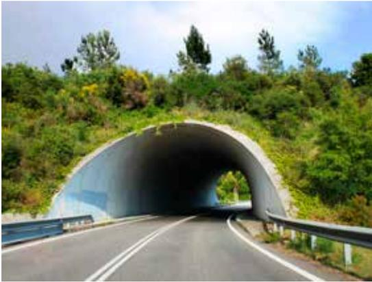
Figura 2.3. Paso situado en un tramo entre desmontes que permite depositar materiales excedentes de la excavación. Foto: M. Fernández-Bou.
