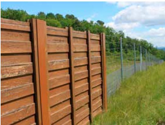
Figura 2.5. Las pantallas del paso deben mantener una perfecta continuidad con el cerramiento perimetral de la vía. Foto: C. Rosell.
