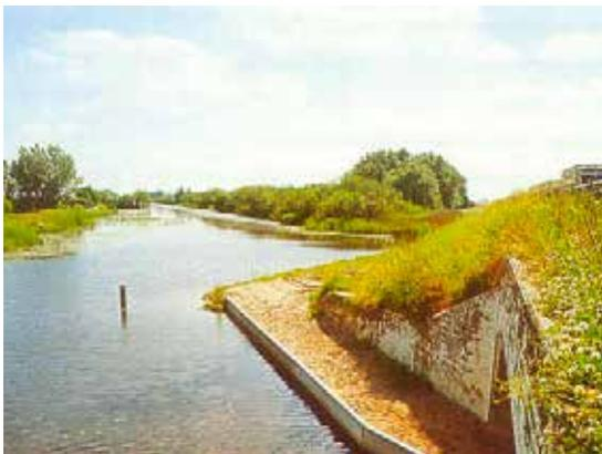
Figura 9.3. Rampa que facilita una óptima conexión de las plataformas secas del drenaje con los hábitats naturales de su entorno. Foto: H. Bekker.
