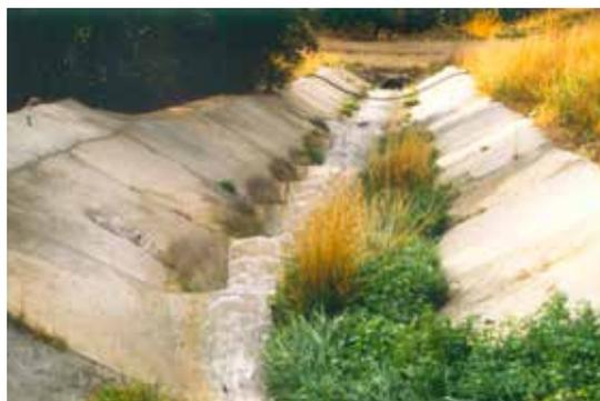
Figura 9.8. Bajante de protección del terraplén con las paredes laterales en pendiente, adaptadas para facilitar los movimientos de fauna. Foto: C. Rosell.
