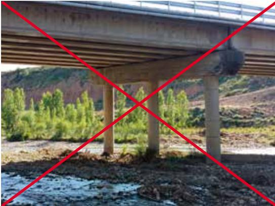
Figura 5.7. Mala disposición de las pilas en el interior del cauce. Foto: F. Navàs.
