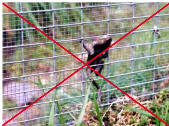
Figura 11.13. Las mallas de alambre galvanizado no son aplicables porque los anfibios intentan trepar por ellas. Foto: R. Campeny.
