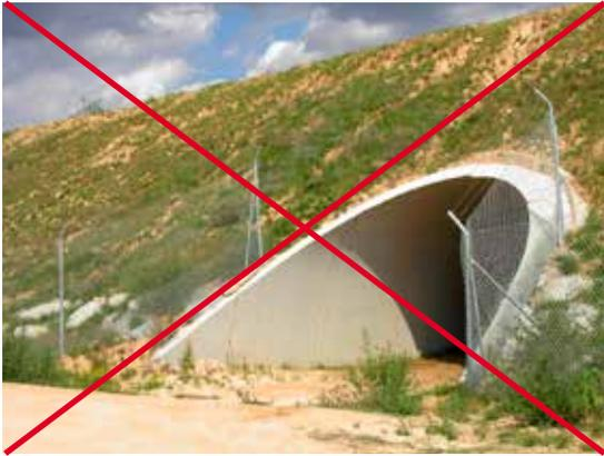
Figura 13.10. La malla debe conducir al paso sin dejar zonas abiertas de acceso al talud. Foto: C. Rosell.
