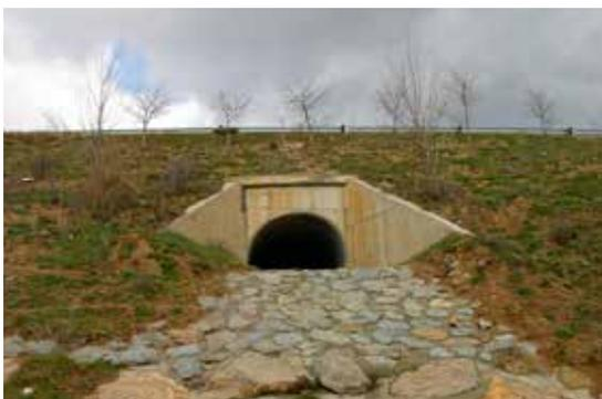
Figura 9.7. Encachado que sustituye un bajante escalonado en la salida de un drenaje. Foto: C. Rosell.
